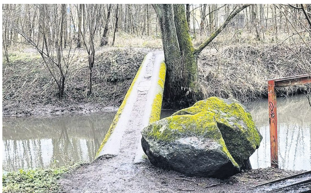
Die provisorische Querung der Weschnitz in der Nähe des Zotzenbacher Bahnhofes ist nicht für die öffentliche Nutzung ausgelegt und wird nun gesperrt.
